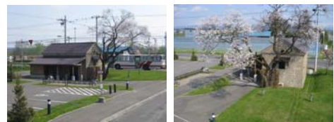
▲交通広場整備 (既存建造物活用事業)
